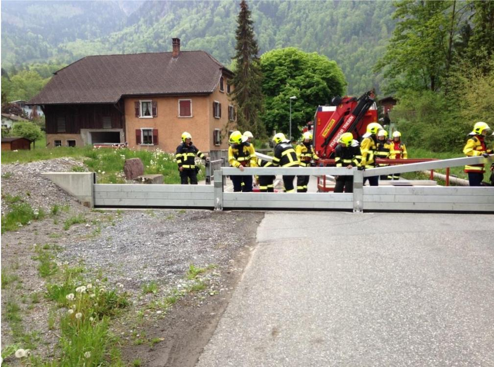
Abbildung 12: Mobiler Schutz Säga, ABS
