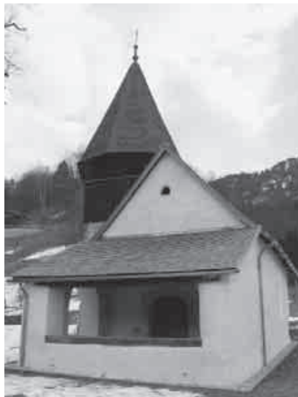
Die Gesamtrestaurierung der Kapelle St. Mamerten in Triesen umfasste die Aussenfassaden samt Dacheindeckung sowie die bedeutenden Fresken aus der Zeit um 1430 im Innen der Kapelle.
