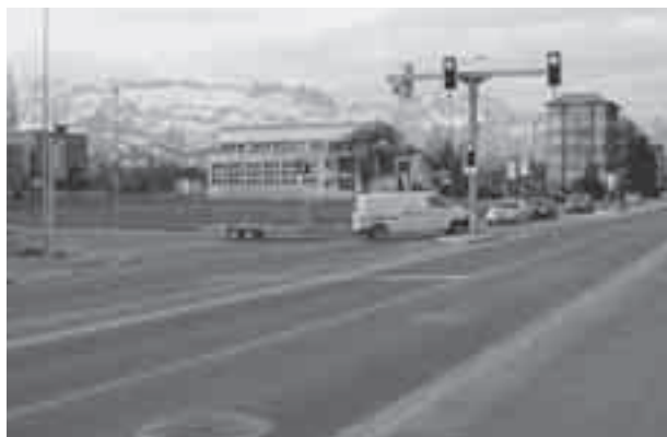
Neue Lichtsignalanlage Heuweg, Vaduz
