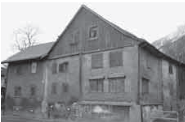
Für die denkmalgeschützten «Landweibelhäuser» in Schaan wurde ein Restaurierungskonzept erarbeitet.
