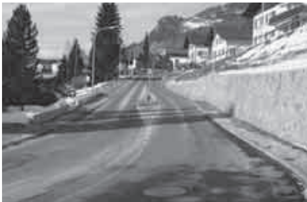
Landstrasse Triesenberg innerorts mit neuem Trottoir und Mittelinsel
