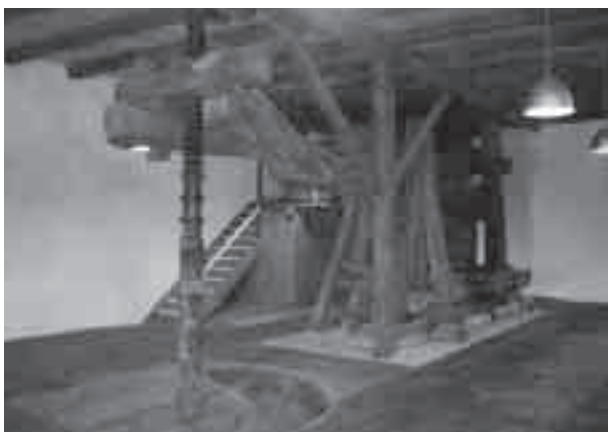
Der Torkel in Balzers wurde restauriert und mit einem modernen Küchen- und Toilettenanbau versehen. Der Torkelbaum stammt aus dem Jahr 1777.
