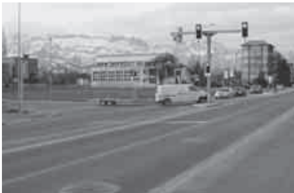
Neue Lichtsignalanlage Heuweg, Vaduz
