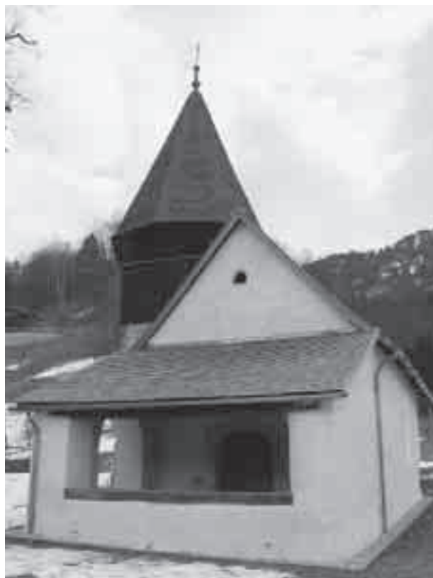
Die Gesamtrestaurierung der Kapelle St. Mamerten in Triesen umfasste die Aussenfassaden samt Dacheindeckung sowie die bedeutenden Fresken aus der Zeit um 1430 im Innen der Kapelle.
